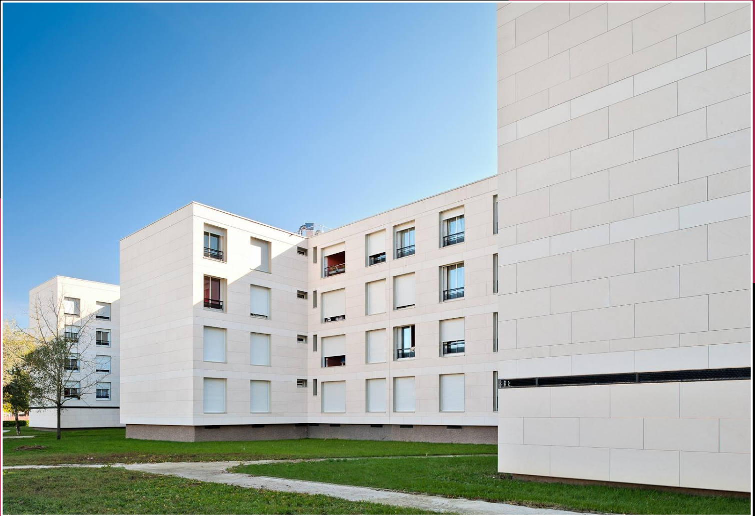
Façade cut to size, France (2012). Stone: Semi-Rijo LR honed and Moleanos LR sandblasted. Façade sur mesure, France (2012). Pierre: Semi-Rijo LR adouci et Moleanos LR sablé.
